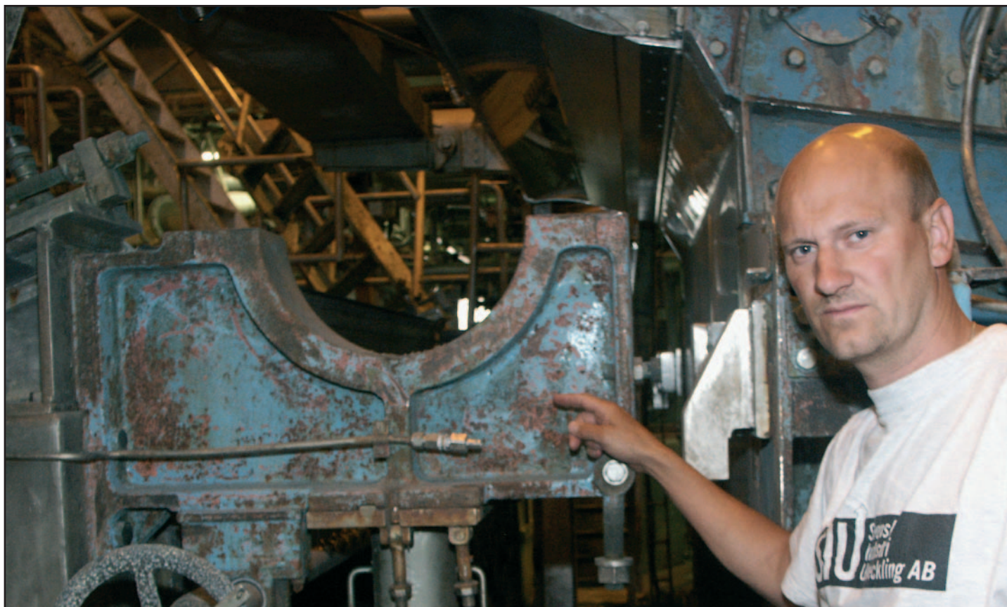
Med den nya metoden går rostangripna partier att blästra i anslutning till pappersmaskinen, om kringliggande känslig maskinutrustning täcks med plast.
